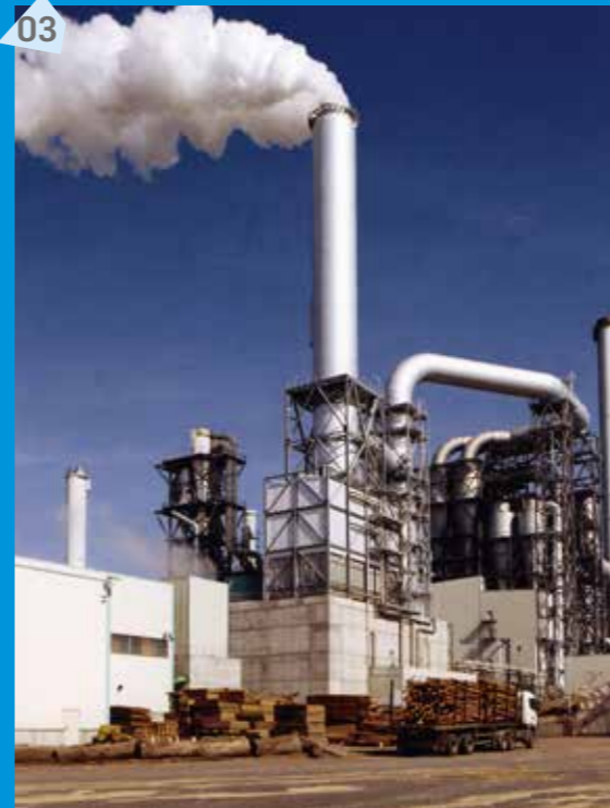
Für Kronospan in Lampertswalde baut Scheuch 2005 den bis dahin größten biologischen Wäscher der Welt.
