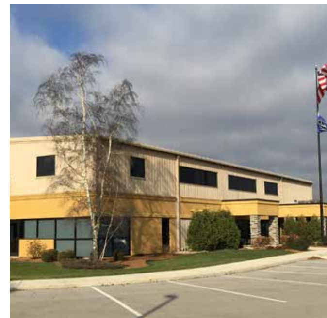
Neues Gebäude der Schust in Auburn, Indiana.
