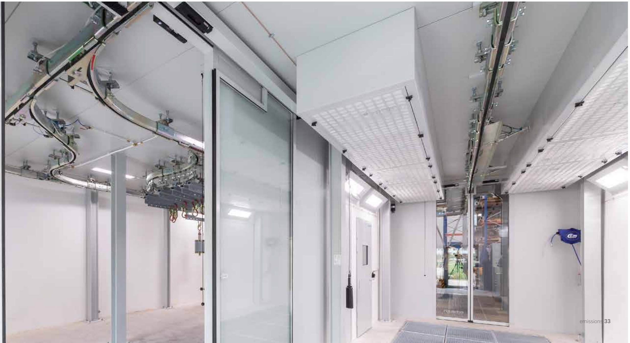
Neue Lackierräume für perfekte Oberflächen.
